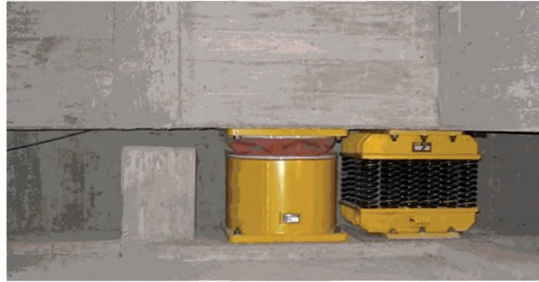
Рисунок В.12 — Установка ТПДС при параллельном размещении блока витых пружин и ВД
